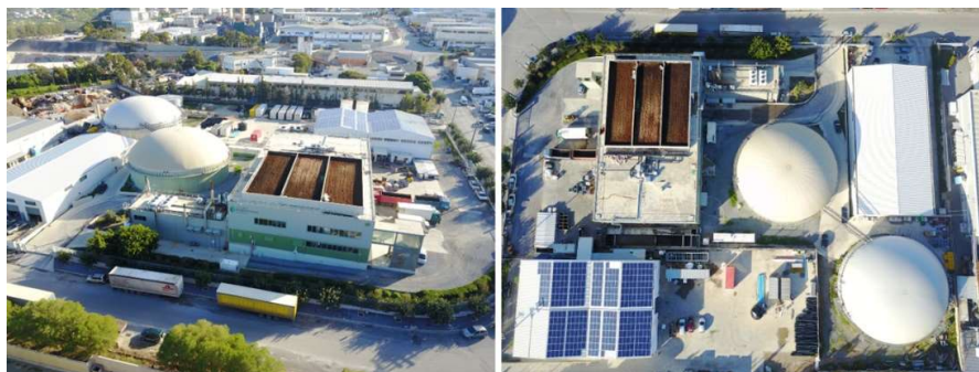
Εικόνα 1. Οι εγκαταστάσεις της εταιρείας ΒΙΟΕΝΕΡΓΕΙΑΚΗ ΚΡΗΤΗΣ ΑΕ στη ΒΙ.ΠΕ Ηρακλείου.
