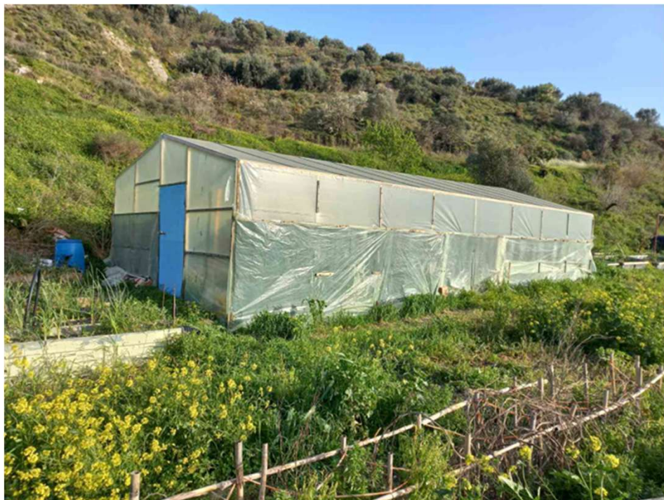
Όψη του θερμοκηπίου που πραγματοποιήθηκε η δοκιμή
